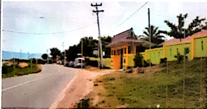
Kondisi Jalur pipa distribusi depan SDN 6 Desa Ujung Karang, Kec. Karang Tinggi
