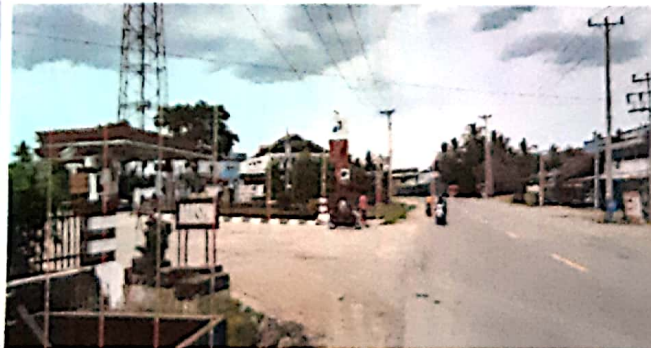
Kondisi Jalur pipa distribusi depan SP3U Kembang Seri
