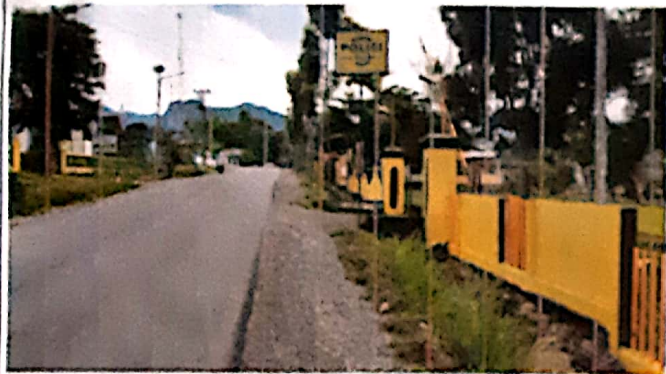
Kondisi Jalur pipa distribusi depan kantor Polsek Taba Penanjung
