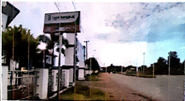
Kondisi Jalur pipa distribusi depan Kantor Bupati Bengkulu Tengah
