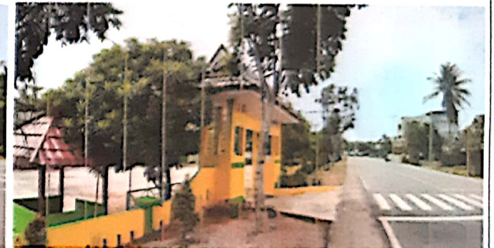
Kondisi Jalur pipa distribusi depan SMPN 5 Bengkulu Tengah
