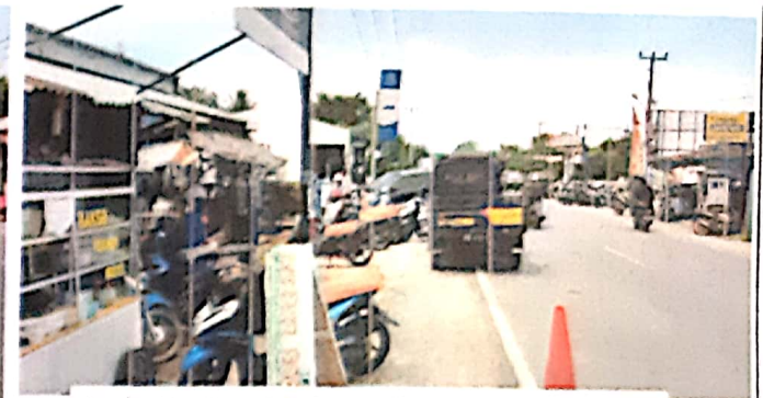
Kondisi Jalur pipa distribusi depan BRI Unit Karang Tinggi yang cukup ramai sehingga akan terdampak kegiatan pengalihan
