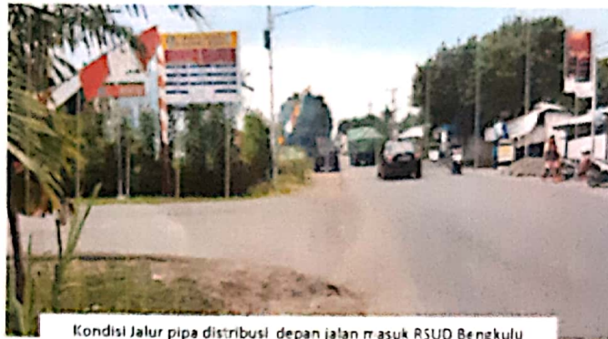
Kondisi Jalur pipa distribusi depan jalan masuk RSUD Bengkulu Tengah, Desa Durian Demang. Penempatan ini cukup ramai, sehingga akan terkena dampak kegiatan pemasangan pipa
